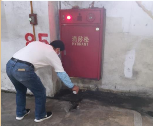
時間:113.08.08 地點:李察王子大樓地下室
