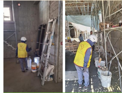
時間:113.07.12 地點:施松汶工地(正義段805地號-中清五街70號旁)
