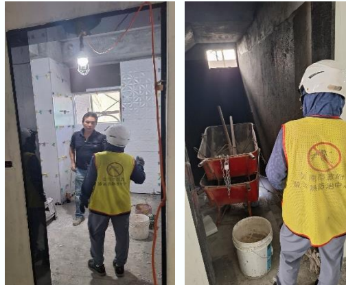
時間:113.07.12 地點:吳瓊玲住宅興建工程(正義路61號旁)
