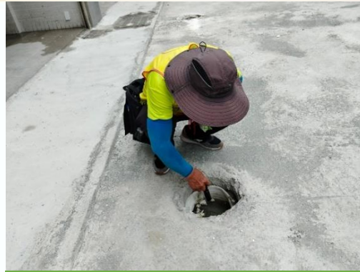
時間:113.07.12 地點:德崙路291巷工地(寶鴻營造)
